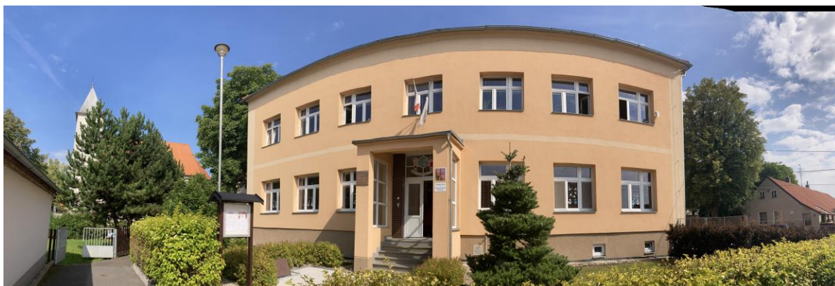
Fotografie 1: Budova školy.
